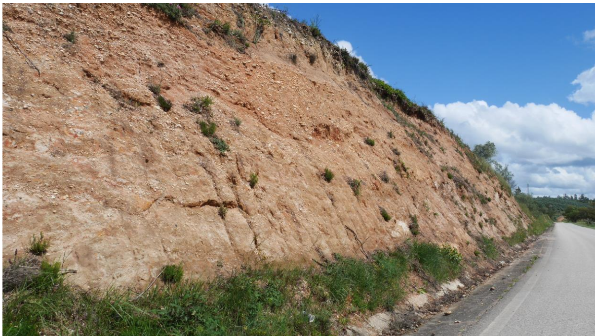
Fotografia 2. Talude do CM 1119 onde se observam os arenitos, as argilas e as margas cretácicos.
